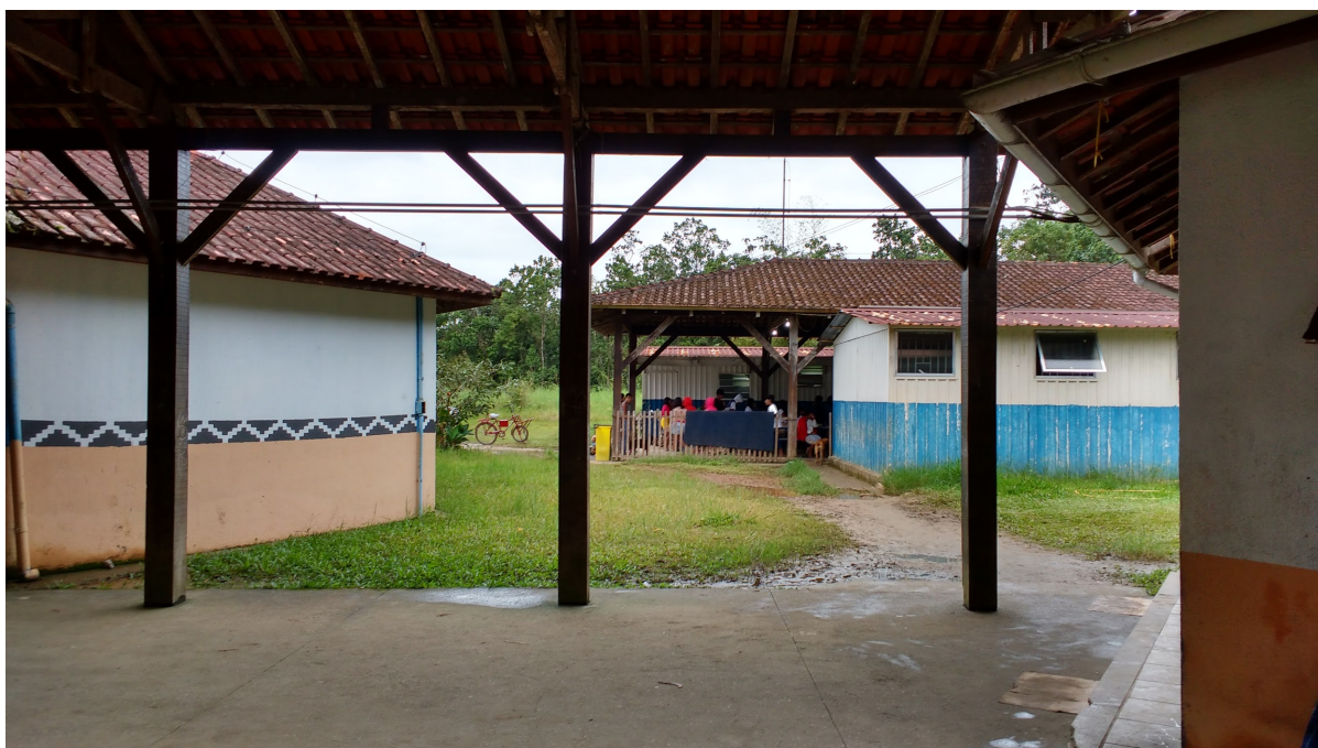
■ À esquerda sala de aula de alvenaria, à direita refeitório e contêineres que abrigam duas salas de aula
